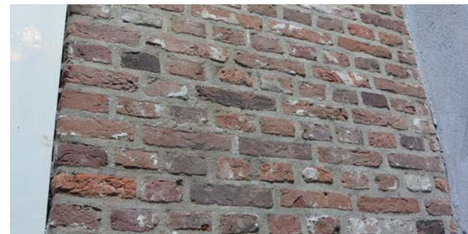
Voorgevel achterhuisje 17-18 x 8-9 x 3.5-4, 10l 50cm, kruisverband rode handvormsteen
