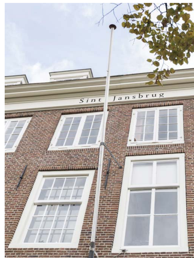
62. Het midden van de gevel, 1e/2e verdieping (links OD52, rechts OD50).
