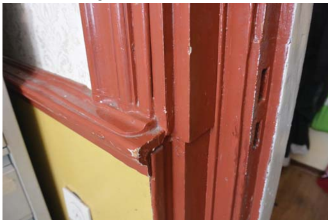
169. Aansluiting bovenrand lambrisering - deurkozijn, in bestuurskamer.
