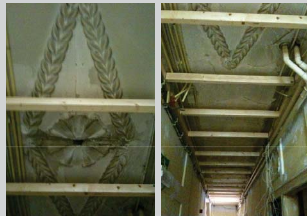
145. Het stucplafond boven het verlaagde plafon.
