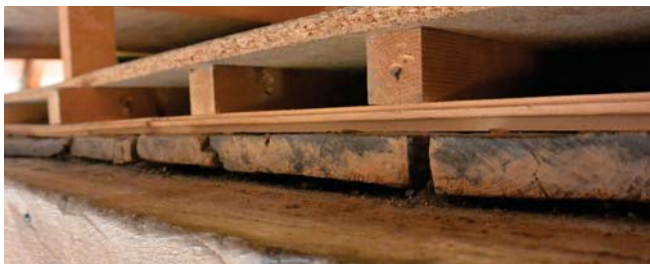
204. Vloerconstructie tweede vloering.
