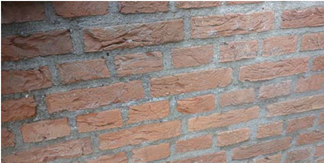
Invulling venster linker zijgevel tussenlid 16 x 8 x 3.5-4, 10l 50.5cm, kruisverband rode handvormsteen
