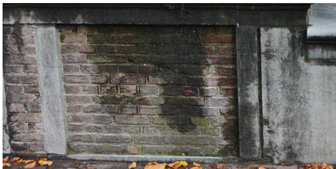
Voorgevel onder bordes 18-19 x 8.5-9 x 4, 10l 51cm, kruisverband paarsige steen handvormsteen
