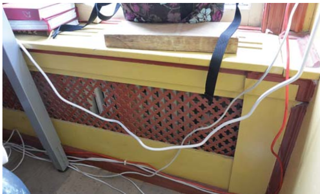
168. De omtimmering van de radiatoren.
