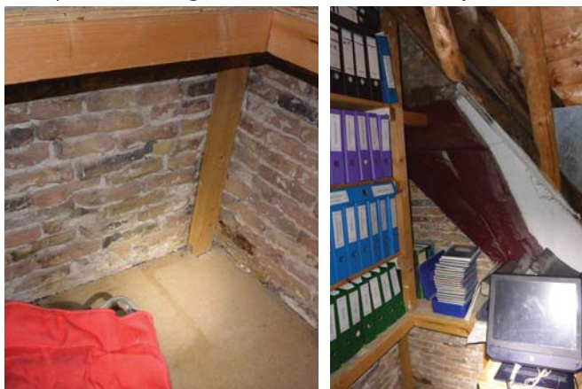
188. Het metselwerk (links) en het spantbeen van het hoofdhuis (rechts).
