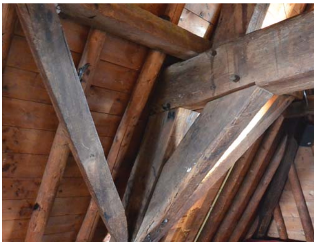
106. Knooppunt bij het tweede juk van spant vijf (kapconstructie B1).
