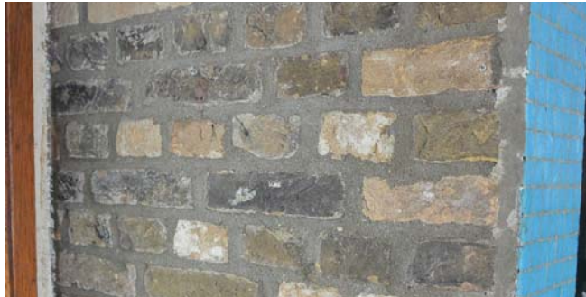
Voorgevel achterhuis 15.5-16 x 7.5-8 x 3.5-4, 10l 49cm, kruisverband gele handvormsteen
