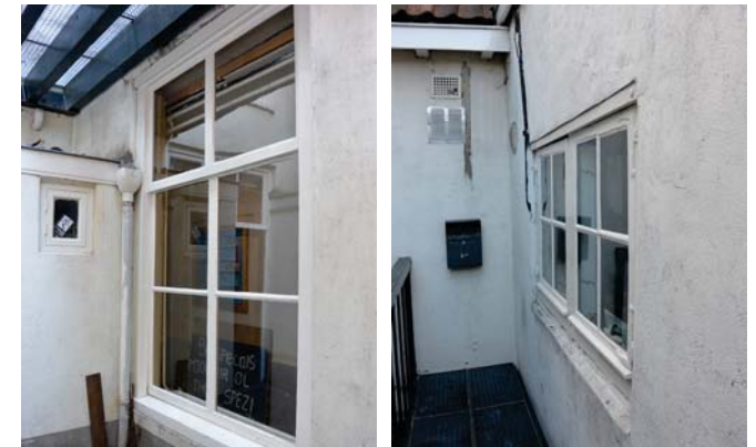
83. Rechter zijgevel hoofdhuis, vanuit de binnenplaats.
