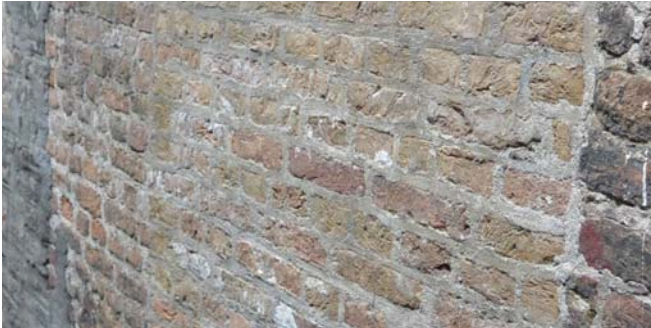
Invulling onder recent raam zijgevel achterhuis 15-17 x 7.5-8.5 x 3-4, 10l 48.5cm, slordig kruisverband geel/roze handvormsteen
