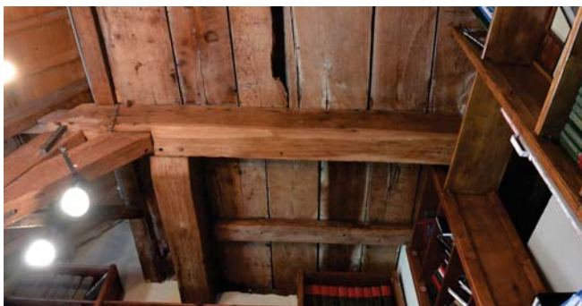
203. De onderkant van de tweede vloeringvloer.
