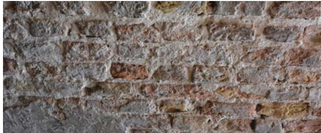
Zijgevel steeg 17-25.5 x 9-12 x 4-5, 10l 63-68cm, onduidelijk verband rode (en gele) handvormsteen
