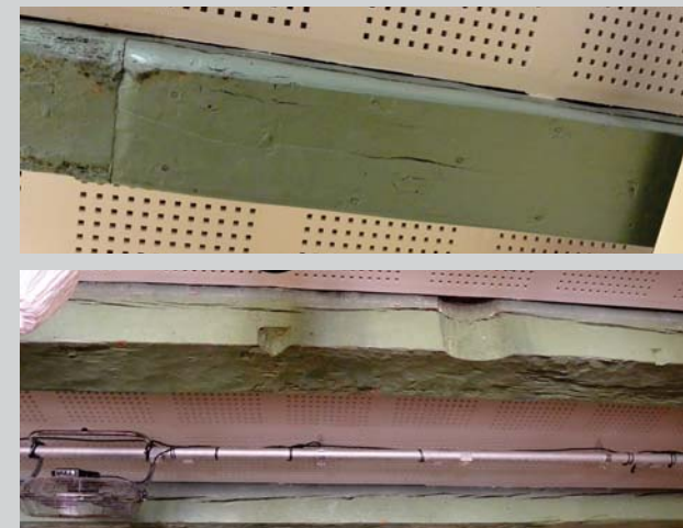
160. Balk met aanheling (boven) en inkepingen (onder) in de eetzaal.
