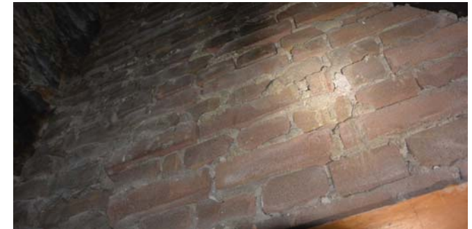
Achterwand rookkanaal oude keuken 20.5-21.5 x 10 x 5, slordig staandverband rode vormbaksteen
