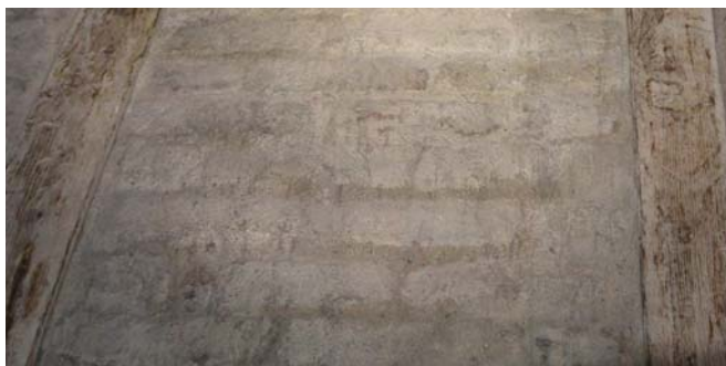
Invullingen/inboetwerk zijgevel steeg 17-19 x ? x 4-4.5, 10l 54cm, halfsteensverband kleur onbekend ivm raaplaag
