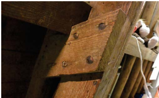
128. Kruising van de afgezaagde hanenbalk en het spantbeen.
