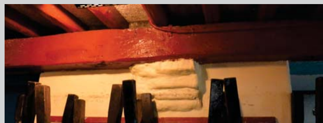
182. De console die de strijk balk ondersteunt.
