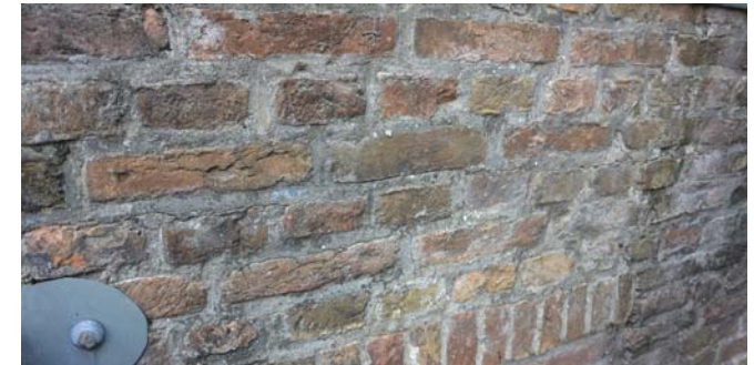
Linker zijgevel tussenlid 18.5-20 x 8.5-9 x 3.5-4, 10l 50cm, kruisverband rood/geel gemêleerd handvormsteen
