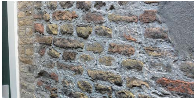
Zijgevel achterhuis onder 16.5-22.5 x 8.5-10 x 4-5.5, 10l 60-65cm, onduidelijk verband geel, oranje, roze handvormsteen
