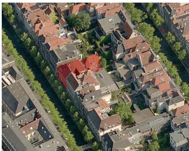
4. Oude Delft 50-52 in het rood, vanuit het zuidwesten.
