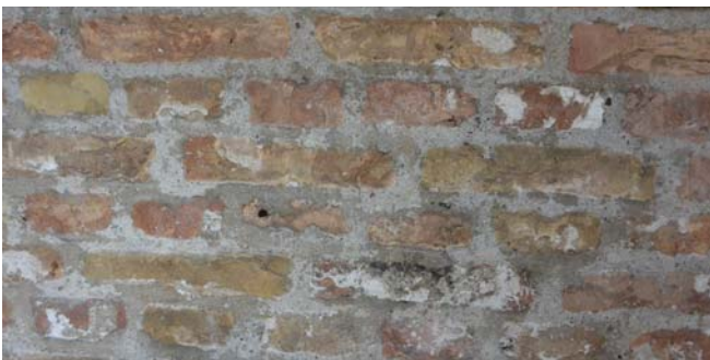
Rechter zijgevel tussenlid (1e verdieping, in halletje) 17-18.5 x 8-9 x 3.5-4, 10l 49cm, kruisverband geel/roze handvormsteen
