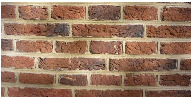
Voorgevel hoofd- en zijhuis 16.5-18.5 x 8-8.5 x 3.5-4cm, 10l 44.5cm, kruisverband roze/rood/paars gemêleerde handvormsteen
