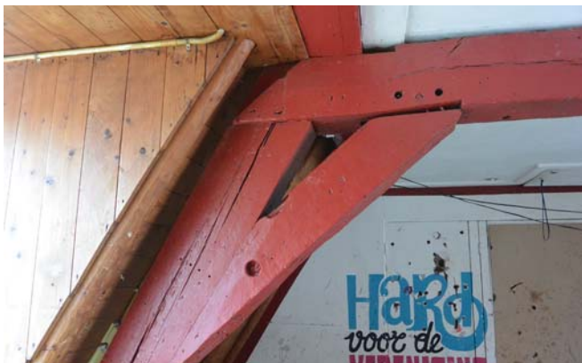
121. Linkerkant spant twee, met gehakte ovaaltjes.
