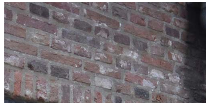
Rechter zijgevel tussenlid (begane grond) 17.5-18 x 8.5 x 3.5-4, 10l 46.5cm, kruisverband rode handvormsteen
