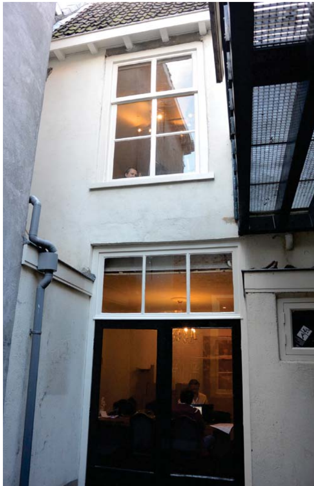
92. Achtergevel zijhuis aanbouw.
