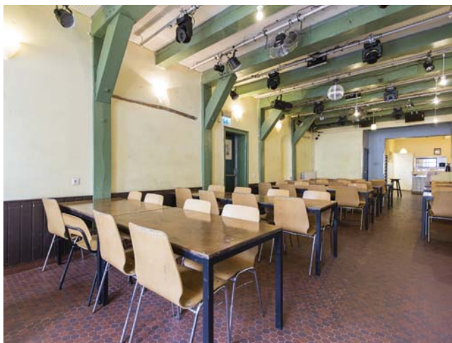
102. Enkelvoudige balklaag op de begane grond.
