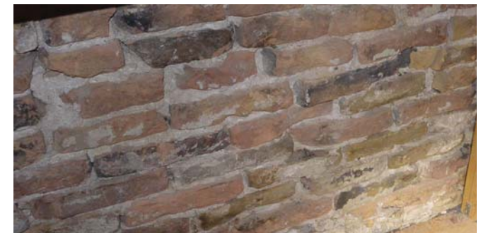
Scheidingsmuur zolder 18-20 x 9-12 x 4-5, 10l 55cm, onduidelijk verband rood/gele handvormsteen
