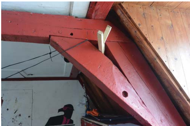
122. Rechterkant spant twee, met gehakte streepjes.
