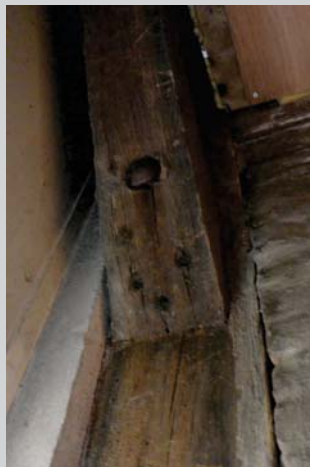
73. Links: achterste korbeel met muurstijl. Rechts: ontlastingsboog.
