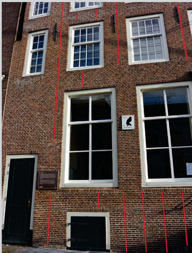
66. Linker deel van de gevel.
