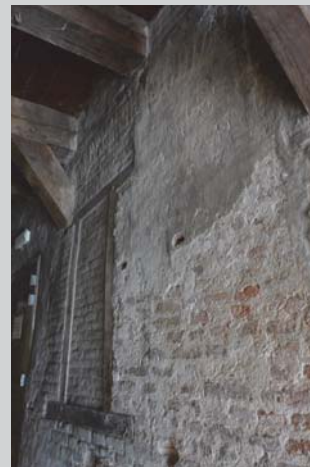
73. Links: achterste korbeel met muurstijl. Rechts: ontlastingsboog.
