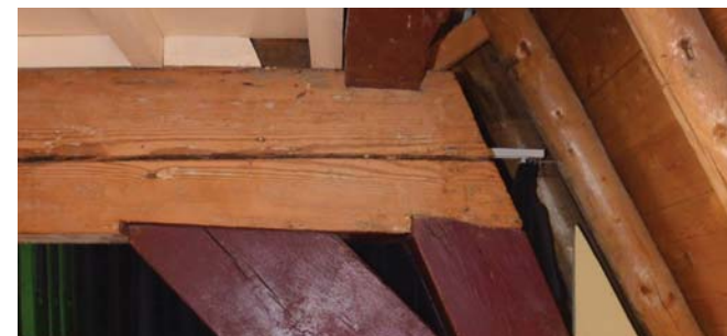
111. Nieuwe dekbalk met nieuw spantbeen en korbeel.
