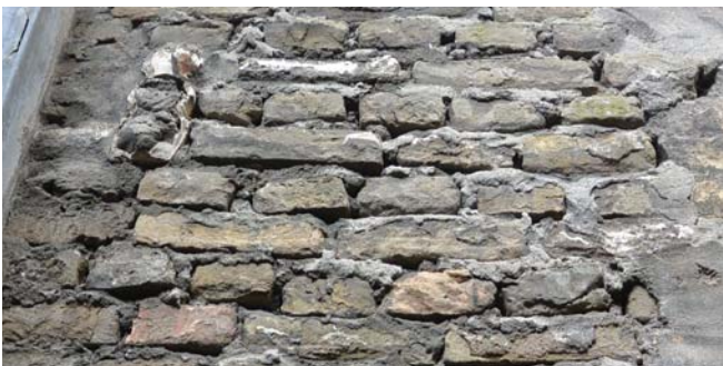
Invulling onder ontlastingsboog zijgevel achterhuis 17-19 x 8-9 x 4-4.5, 10l 52cm, slordig staandverband geel/roze handvormsteen
