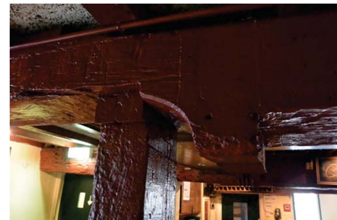
180. Uitstulping, met verjonging in de vijfde moerbalk, met extra kolom.
