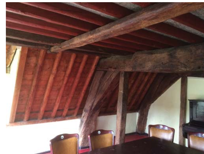
104. Het eerste juk met krommers (kapconstructie B1).
