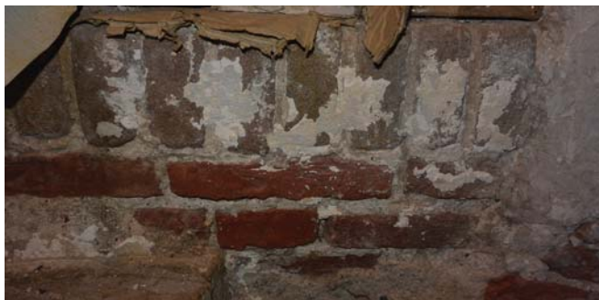
Kwarttrap bij houtkelder 18.5-19 x 9 x 4cm rood/paarse handvormsteen
