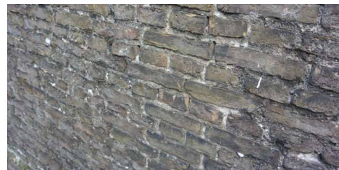
Zijgevel achterhuis boven links 17-17.5 x 8.5-9 x 3.5-4, 10l 45.5cm, slordig kruisverband kleur moeilijk te zien, handvormsteen
