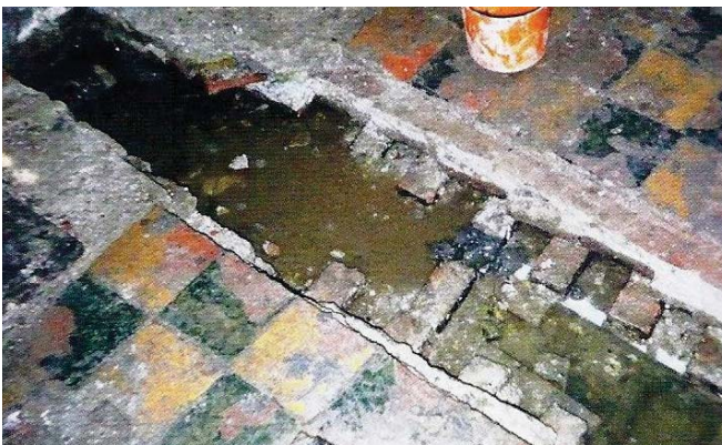
100. Vloerconstructie Nieuwe Langendijk 26.
