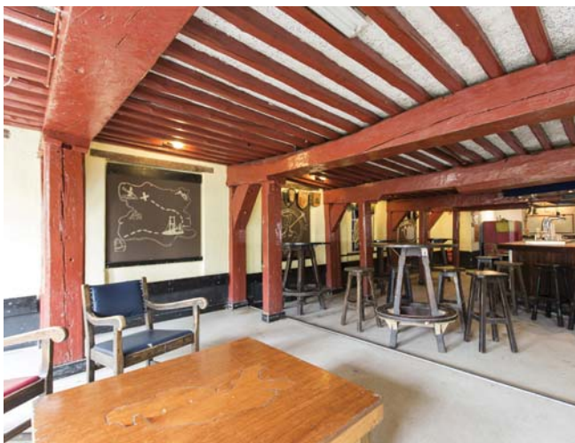
103. Samengestelde balklaag op de verdieping.
