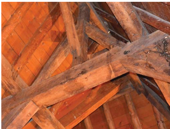
105. De nokstijl op het derde juk (kapconstructie B1).
