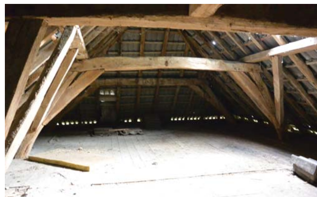
Afb. 73: Kapconstructie bouwdeel A
