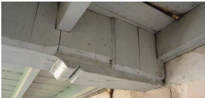
Afb. 69: Sleutelstuk in A-2-1, eenvoudig ojief ("O")
