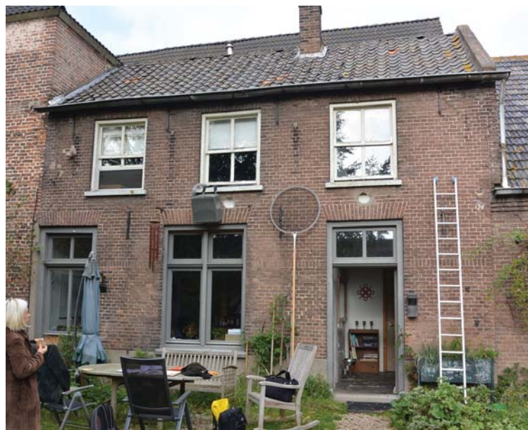
Afb. 46: Zuidoost gevel, bouwdeel B
