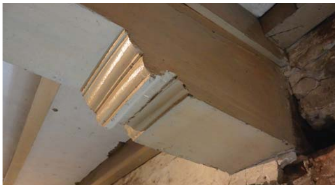
Afb. 67: Sleutelstuk in A-1-2, hangende peerkraal ("P")
