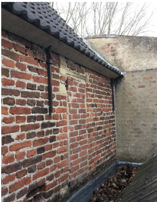
Afb. 61: Rechter deel "voorgevel" bouwdeel A3 en muur bouwdeel A4 (rechts)
