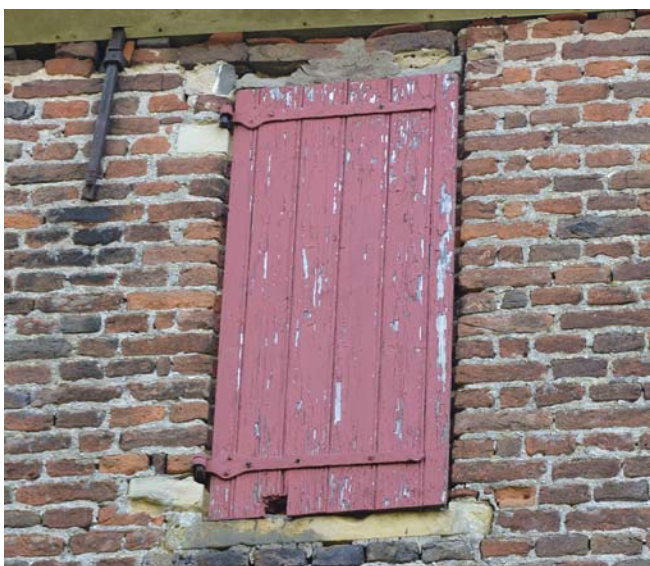
Afb. 81: Boven: onderkant van een kloostervenster, vervagen door schuifraam. Onder: onderkant van een kloostervenster, nog met luik
