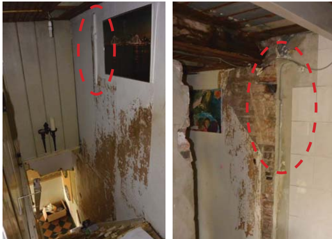
Afb. 110: Ruimte B-1-1, met de gevelankers in de cirkels
