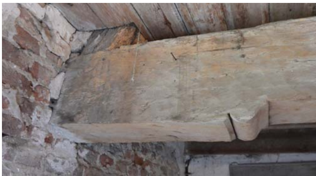
Afb. 70: Sleutelstuk in A-2-2, eenvoudig ojief ("O")
