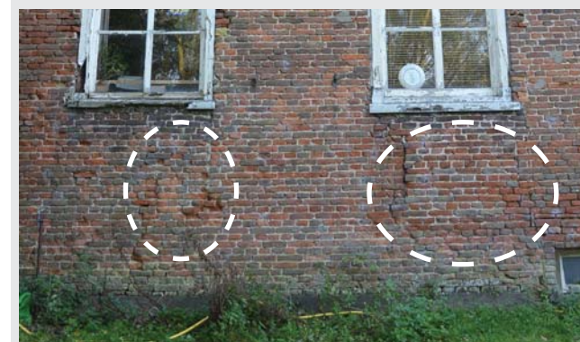
Afb. 51: Noordwest gevel, links onder (sporen van vensters)
