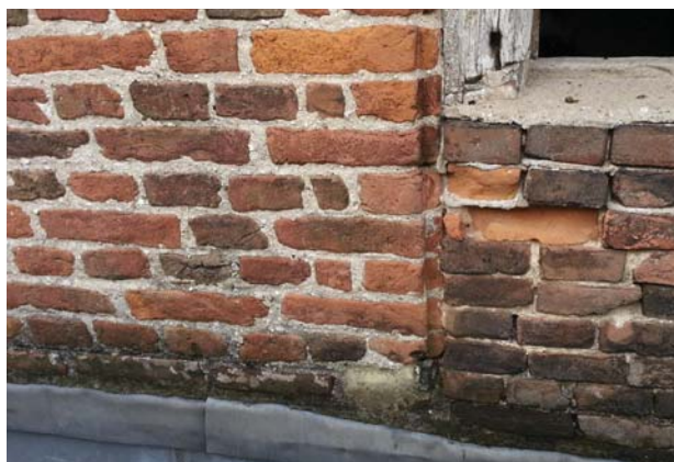
Afb. 60: Sporen van een kruiskoosijn in de “voorgevel” van bouwdeel A3
