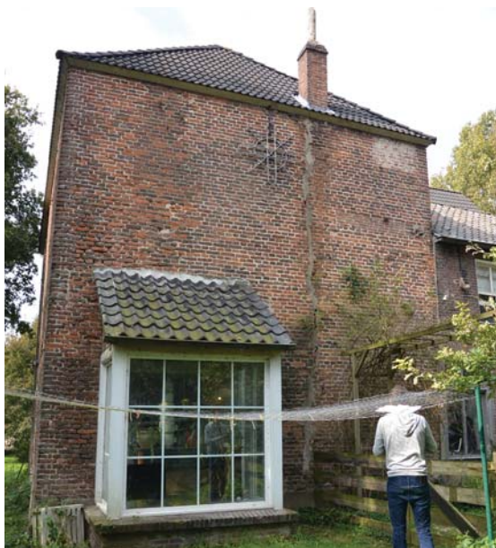
Afb. 45: Zuidoost gevel, bouwdeel A
