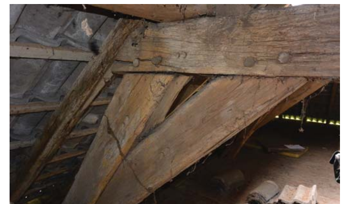
Afb. 74: Telmerken op de kapconstructie van bouwdeel A
