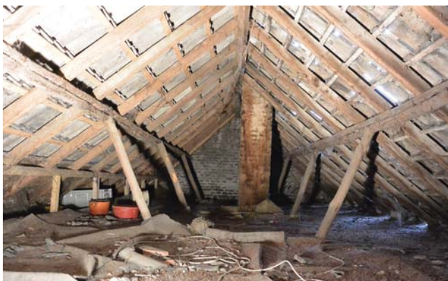
Afb. 76: Kapconstructie bouwdeel B
