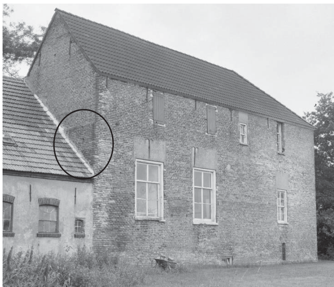
Afb. 56: Verdikking van de muur van bouwdeel A4 tegen bouwdeel A3
