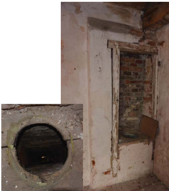
Afb. 97: Het gemakje in ruimte A-2-3 (interieurelement nr. 15)
