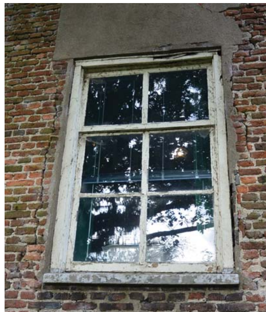
Afb. 48a: Linker venster eerste verdieping
