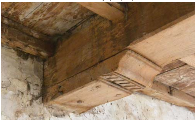
Afb. 71: Sleutelstuk in A-2-3, ojief met tandversiering aan de onderkant ("O")
