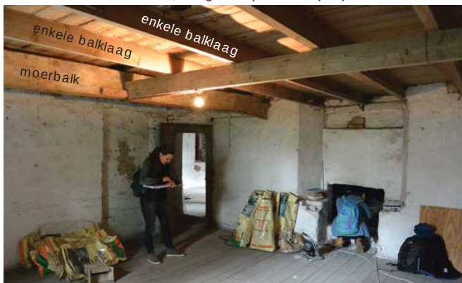
Afb. 68: Constructie in ruimte A-2-2, met moerbalk en enkele balklaag
