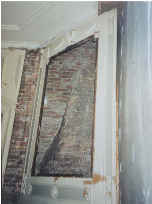
68. Schoorsteenboezem na verwijderen schilderij, 1996.
