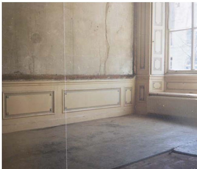
56. De voorkamer tijdens de restauratie, 1996.
