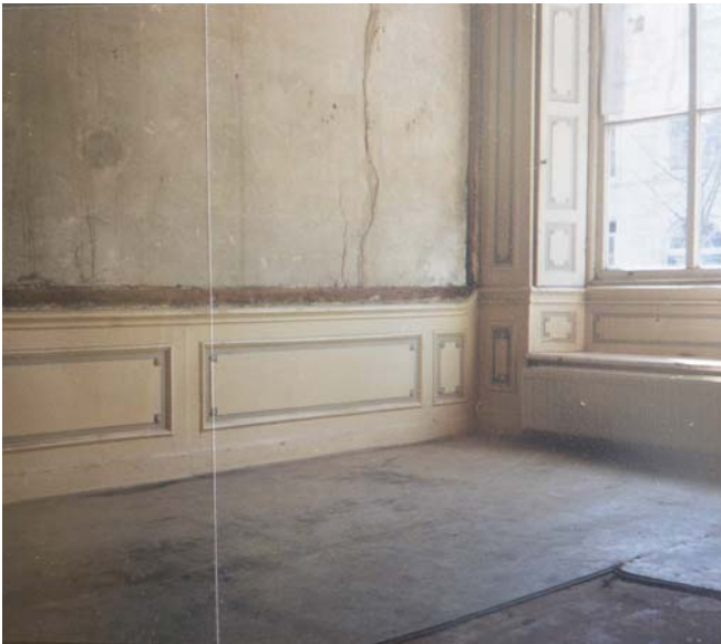
37. Foto eind bouwfase 6, 1996.
