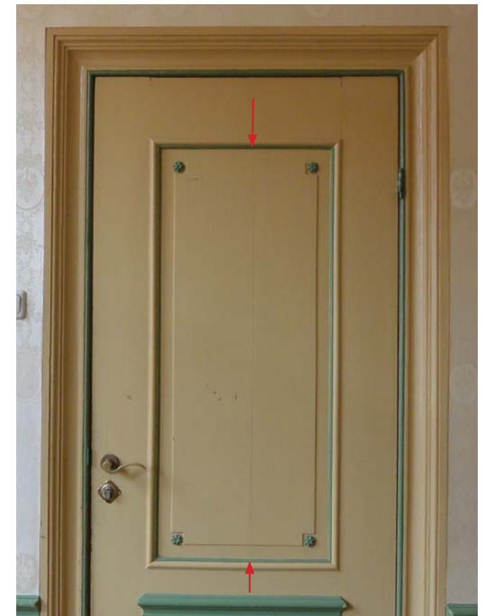
96. Paneel in deur naar gang gescheurt in het midden (bij rode pijlen).
