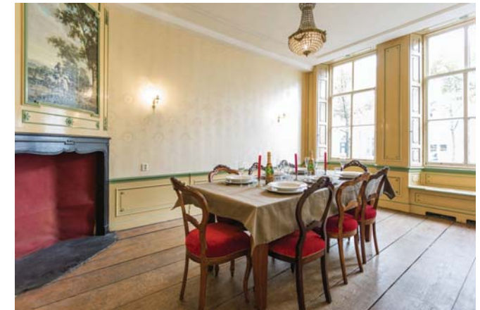
28. Vloer en plafond.
