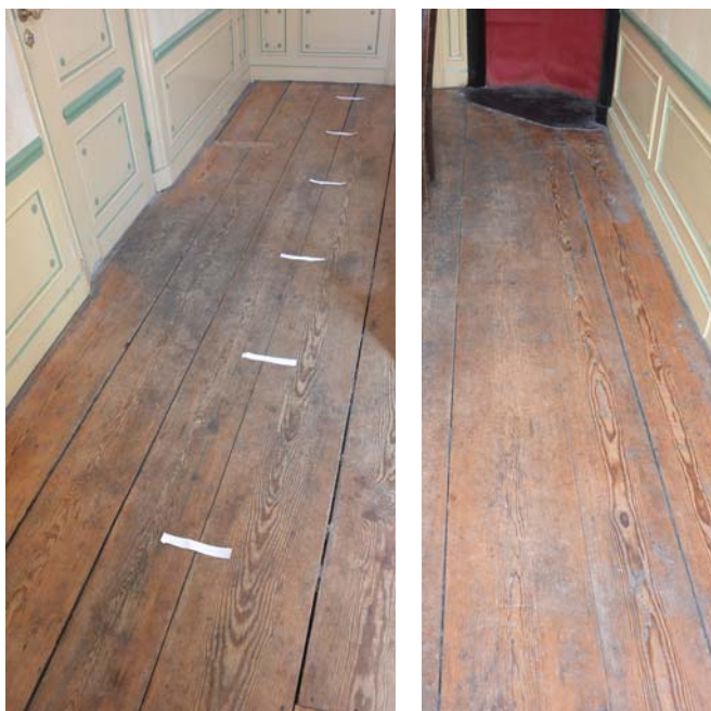
77. De huidige grenen vloer, onder de witte strepen liggen vloerbalken.
