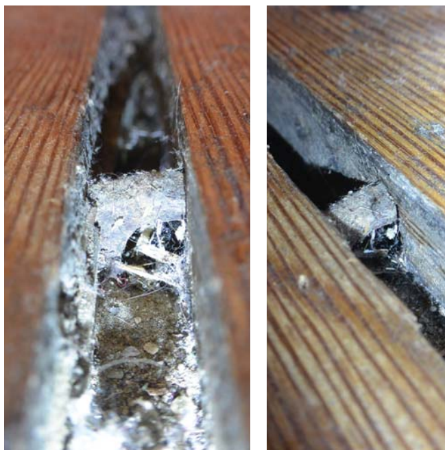
78. Stalen strips onder de vloer.
