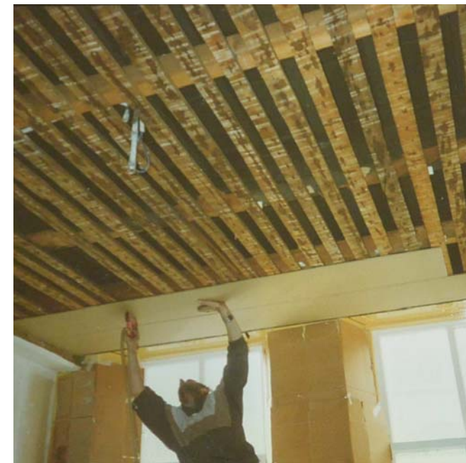
82. Aanbrengen plaatmateriaal voor het huidige plafond, 1996.
