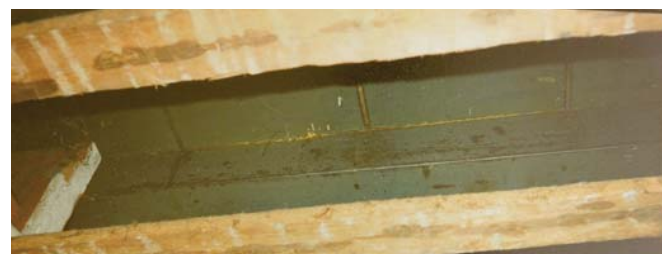
83. Samengestelde balklaag boven rinkellatten, 1996.
