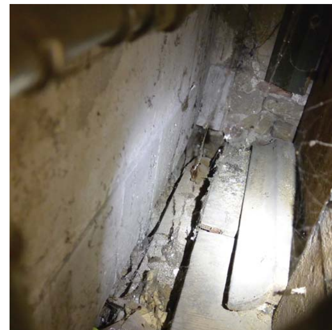
79. Plint met witjes en pleisterwerk en beëindiging grenen vloer.
