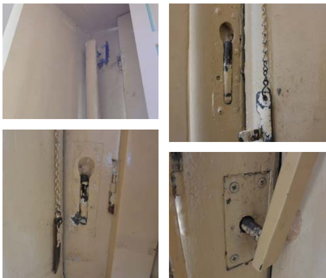
55. Details van sluitbomen (diagonaal boven en horizontaal onder).
