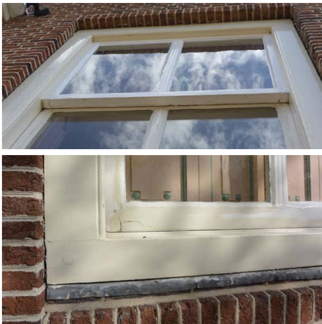
43. Constructie van raam en kozijn.
