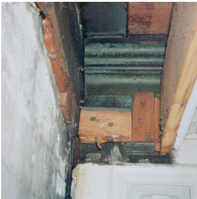
84. Vensterwandbetimmering boven stucplafond, 1996.
