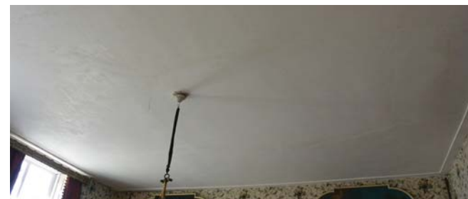
48. Overzichtsfoto plafond achterkamer.
