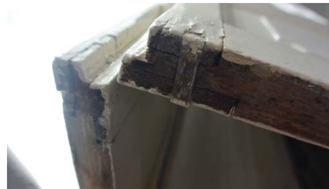
63. De vouwblinden van de onderkant, met de verbinding tussen stijl en regel, aan de doorgezaagde toognagel is te zien dat de vouwblinde is ingekort.
