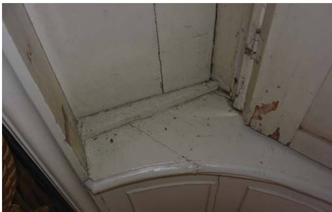
62. De binnenkant van de blindenkast, met rechts de eerste blinde.
