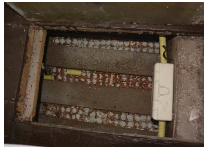
49. Stuc op steengaas in de voorkamer.
