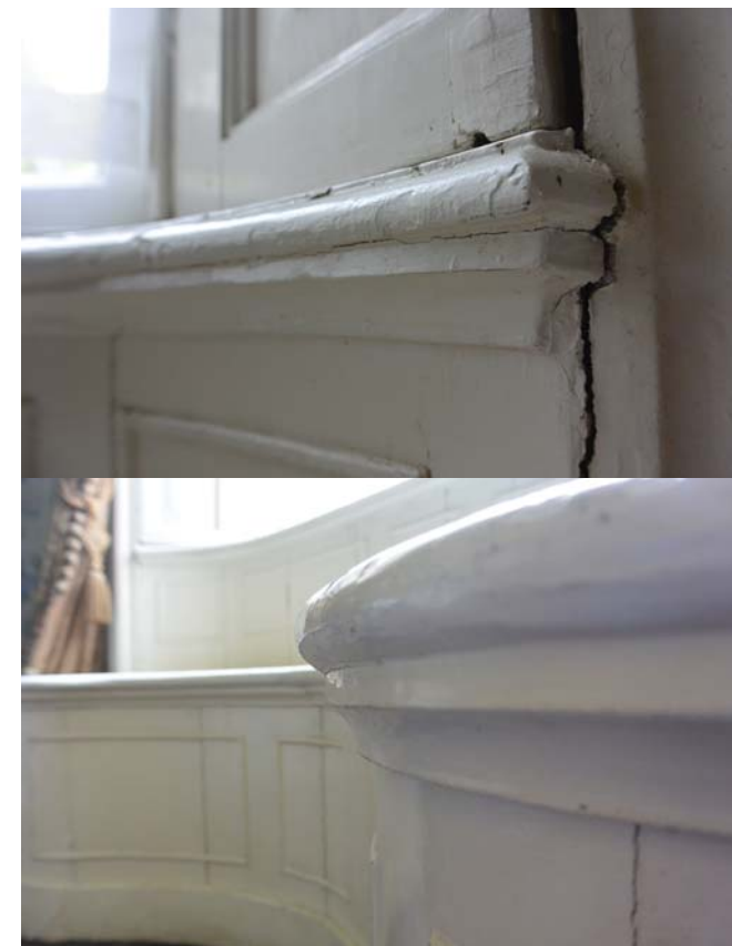
70. De profilering van de rand van de zitting en plank boven leuning.
