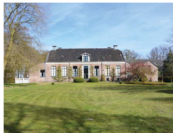
4. De achtergevel van Oldengaerde.
