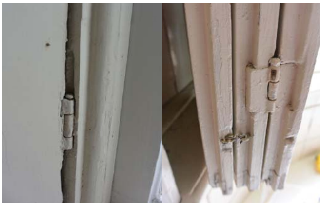
61. Scharnieren op kozijnlat (links) en tussen vouwblinden (rechts).
