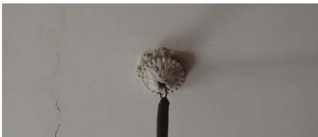
45. Detail plafond achterkamer.
