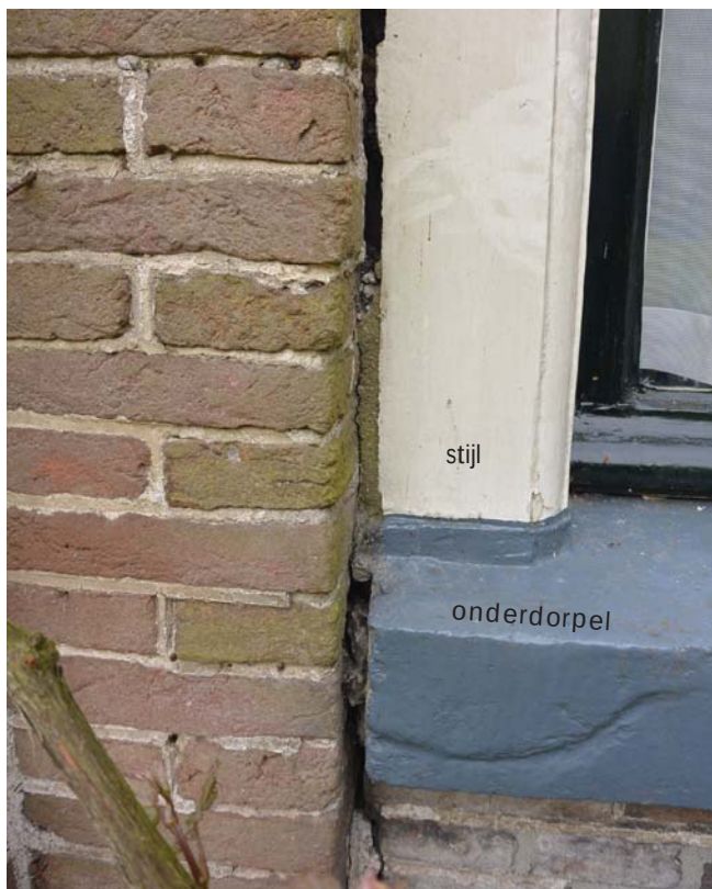
54. Aansluiting van kozijnstijl op onderdorpel.
