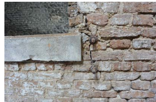
Gebaste stenen door roestend ijzer.
