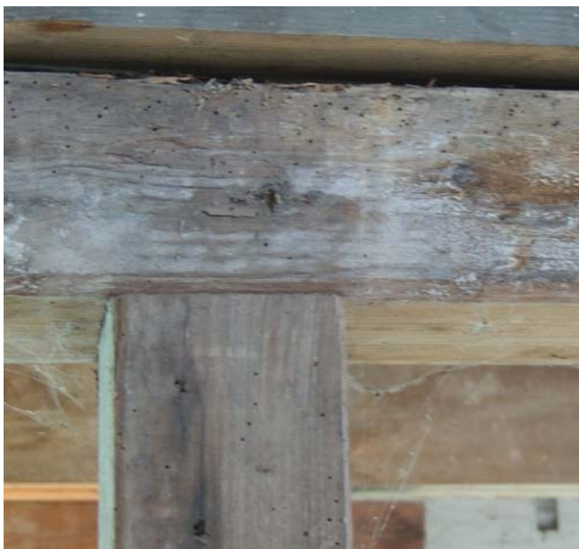
85. Kolom en slof met houtworm aantasting.
