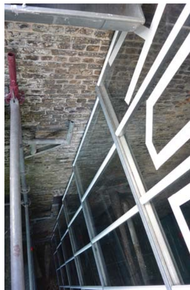
28. Glazen gevel tussenlid (westgevel).
