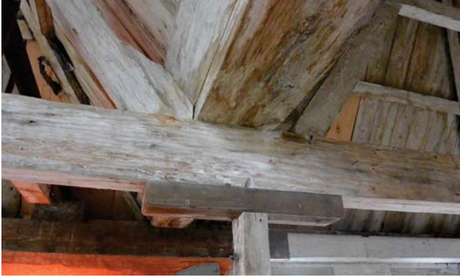
55. Zakgoot aan de oostkant (water), op het oog in redelijke staat.
