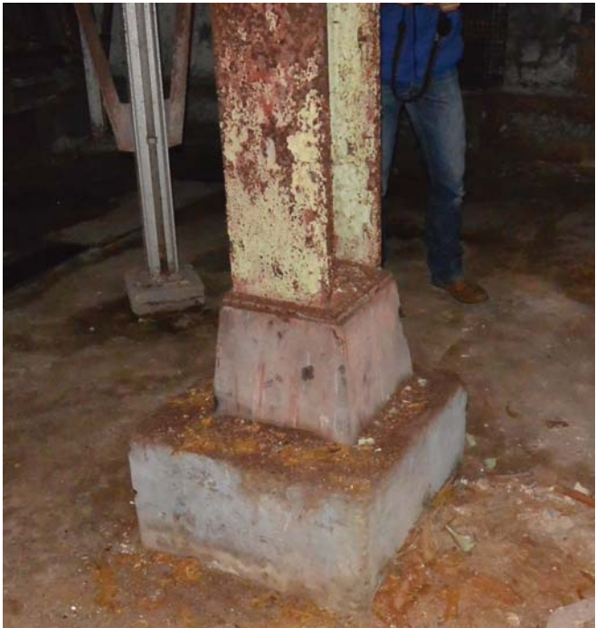
Roestende kolom met afgebladderde verf op natuursteen poer.
