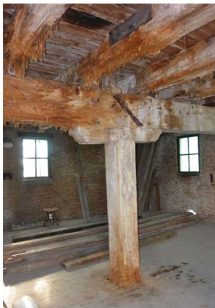
74. De vervezeling van hout in het middendeel, links op de tweede verdieping en rechts op de eerste verdieping.
