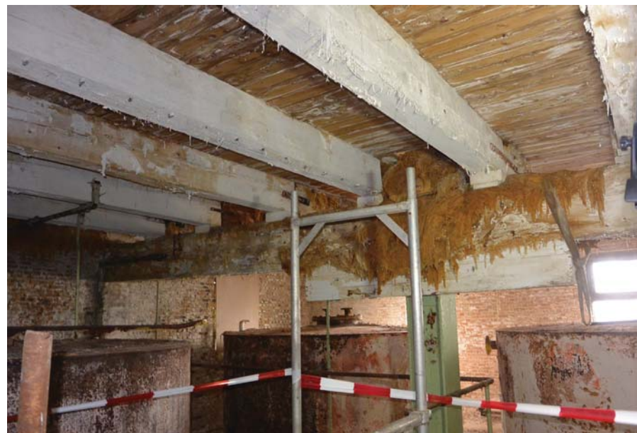
74. De vervezeling van hout in het middendeel, links op de tweede verdieping en rechts op de eerste verdieping.
