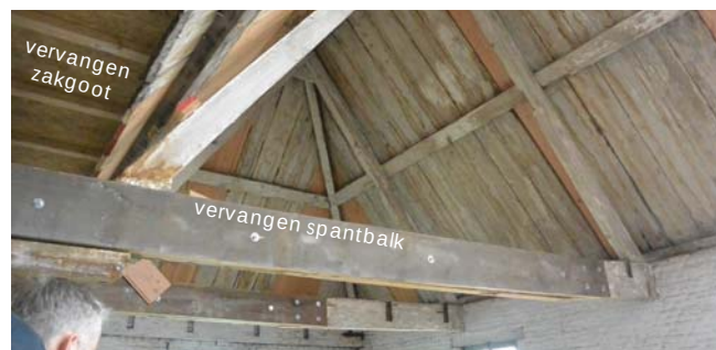
69. De vervangen zakgoot en spantbalk.
