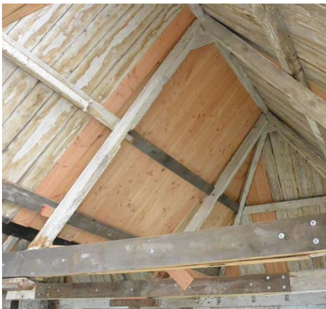
79. Vervangen dakbeschot en spantbalken (noordkant).
