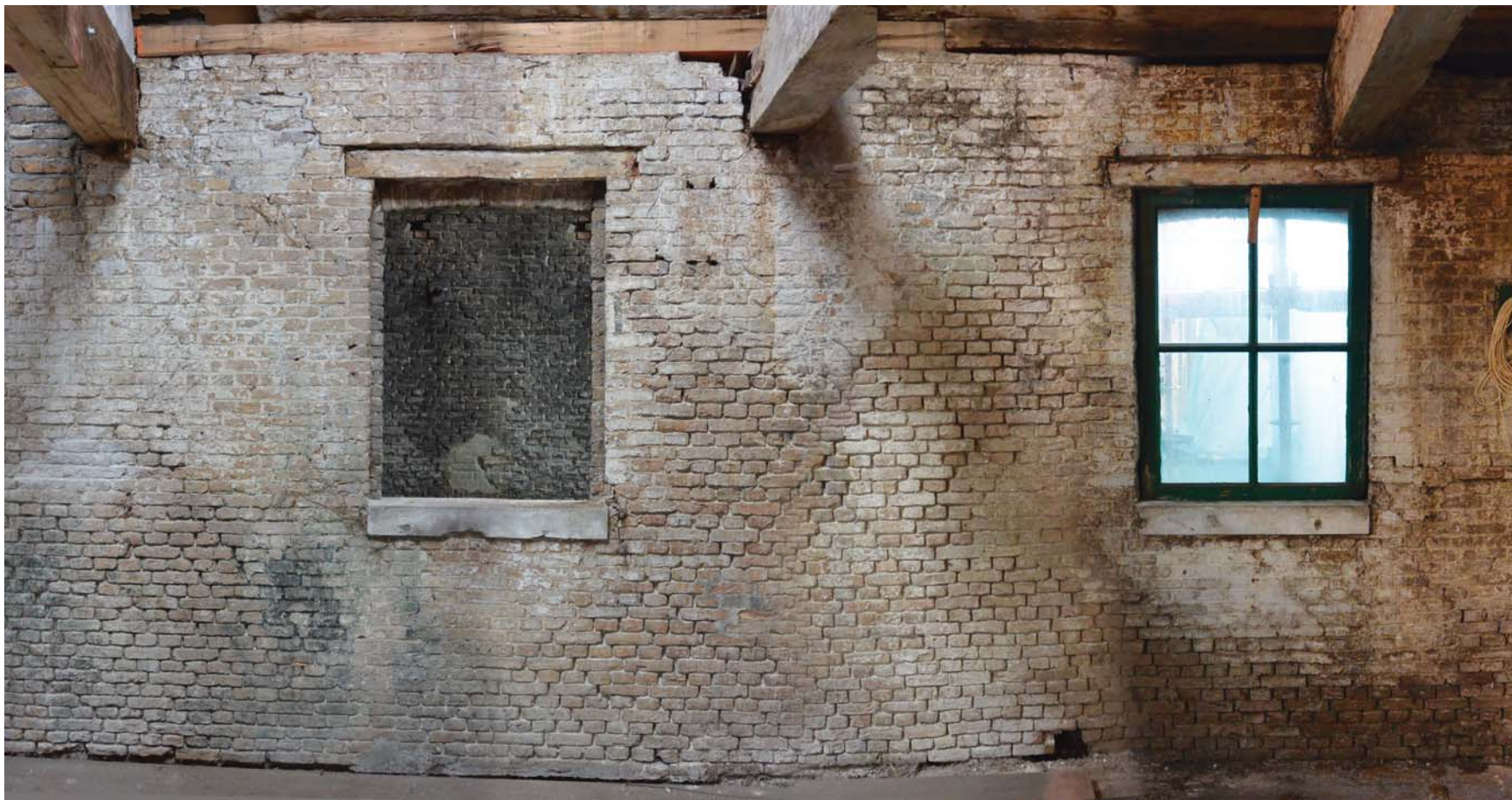
Binnenzijde zuidgevel (3e verdieping).
