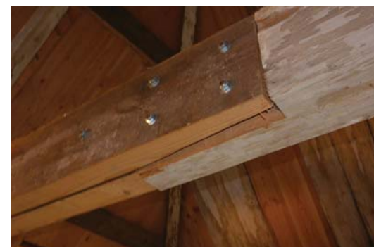
Deels vervangen spantbalk.
