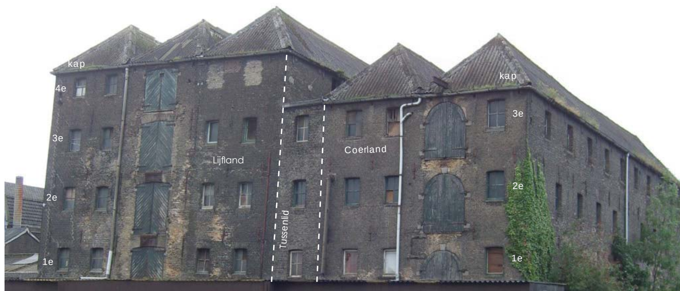
23. Oostgevel, vanaf het water, begane grond en deel van eerste verdieping niet zichtbaar. En noordgevel.
