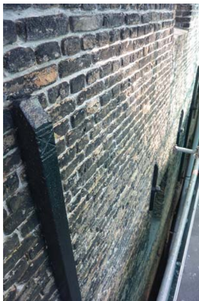
27. Forse, lange gevelankers Coerland.
