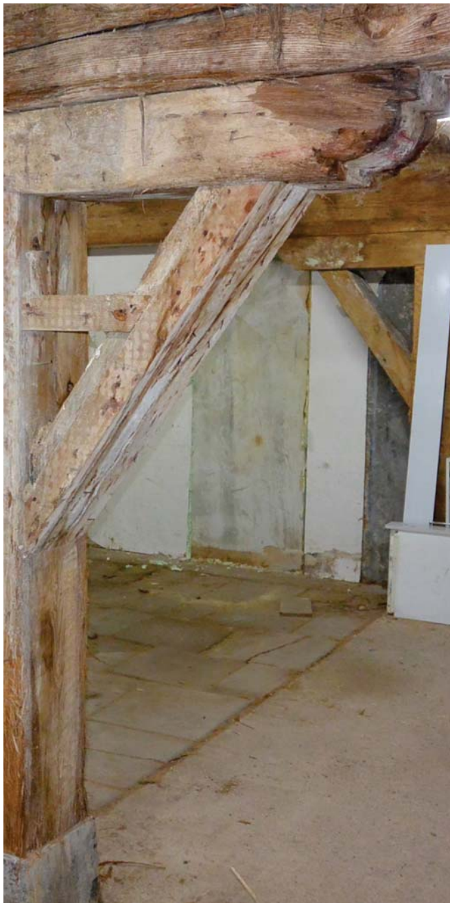
43. Standvink met korbelen en duivenjager profiel, bg Lijfland.
