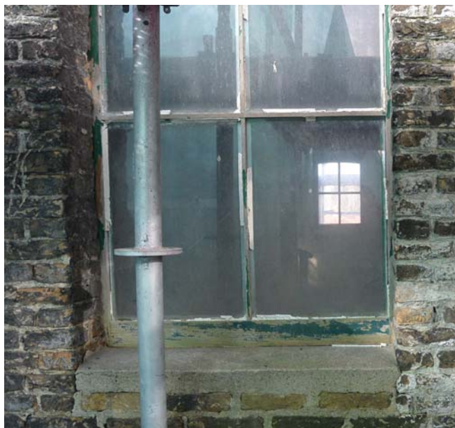
88. Missende stopverf en afbladderende verf.
