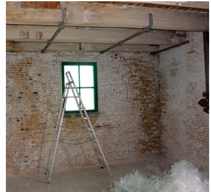
48. Gevelankers achtergevel aan derde balk (Coerland).
