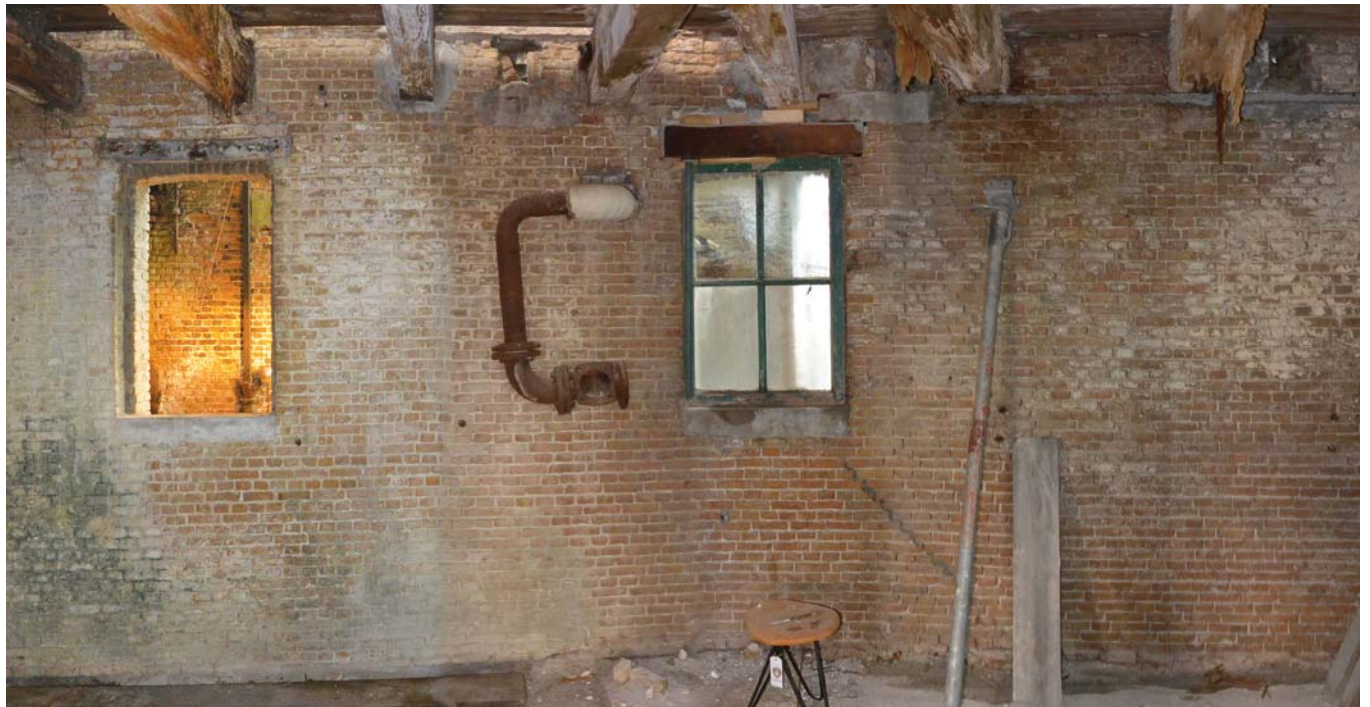
Binnenzijde zuidgevel (2e verdieping).
