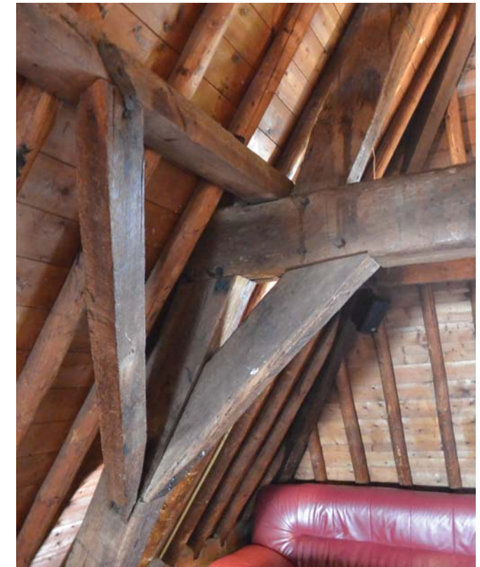
33. Knooppunt van verbindingen (Spant V, tweede juk).
