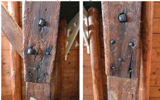
35. Voorbeelden van configuraties van nagels in korbelen.
