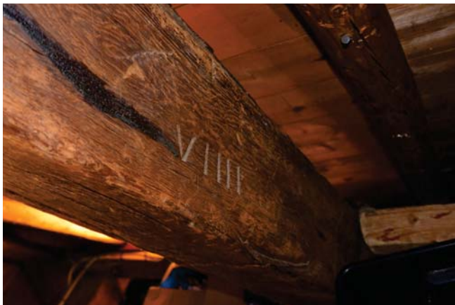
46. Tweede set (rondlopende) telmerken (I t/m VIIII), rechterkant spant V.
