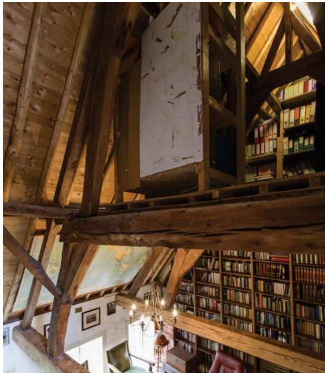
64. De kapconstructie van het zijhuis.
