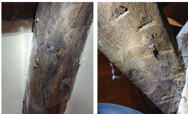
34. Kraslijnen t.b.v. niet (meer) aanwezig blokkeel.
