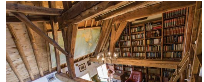
66. De kapconstructie van het zijhuis (tweede juk).
