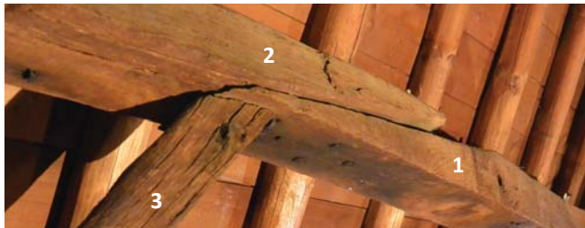
39. Fliering - fliering. Boven richtlijn, midden zonder nagels, onder met.
