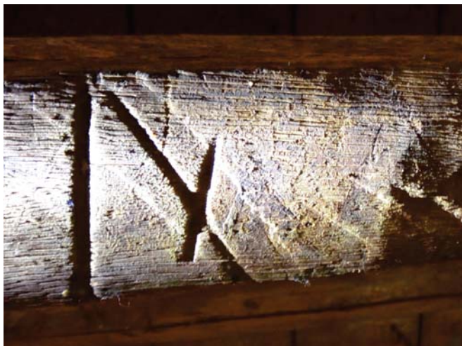
54. Vlotmerk op linker spantbeen II, derde juk.
