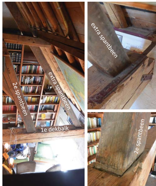
70. Spantbeen en extra spantbeen op eerste dekbalk.
