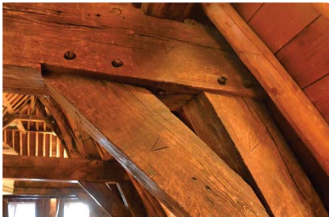
45. Eerste set telmerken (I t/m V), tweede juk spant V.
