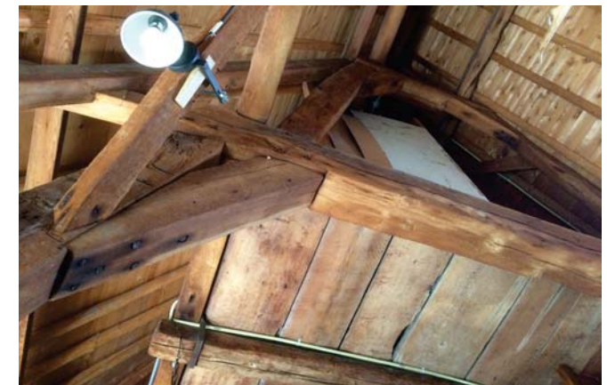
65. De kapconstructie van het zijhuis (tweede en derde juk).
