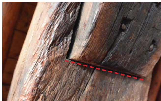
36. Boven: tand over volle breedte. Onder: tand smaller dan spantbeen.
