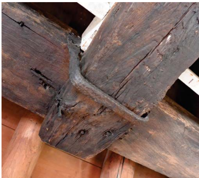
44. Hangbalk met strop en nagels onder flieren gehangen.
