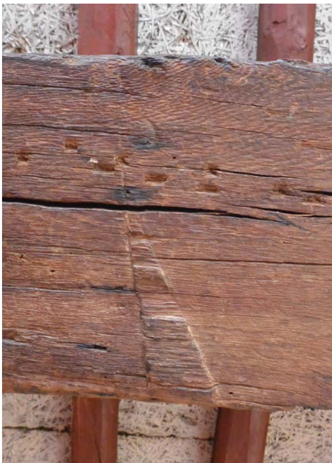
28. Zaagddriehoekje op de onderkant van dekbalk I eerste juk.
