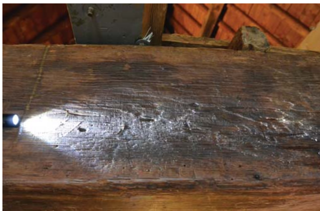
27. Boven behakt (links oud en rechts nieuw), onder gezaagd.
