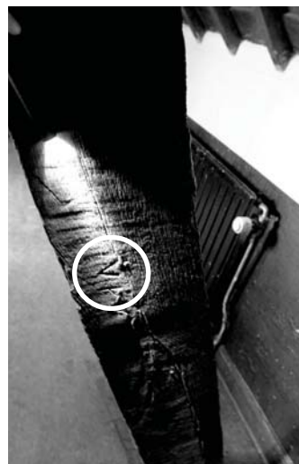
Telmerk VI op spantbeen.
